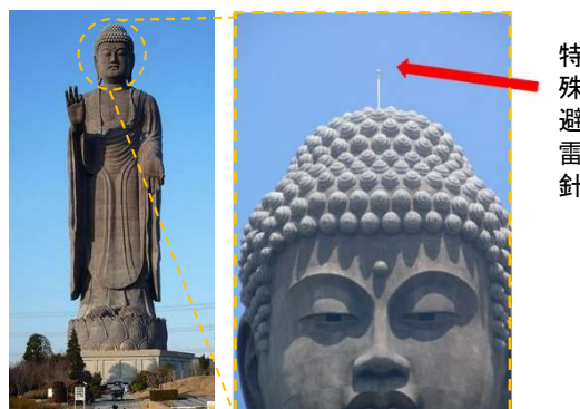
図2 特殊避雷針の設置例 （牛久大仏の頭頂部への設置）
