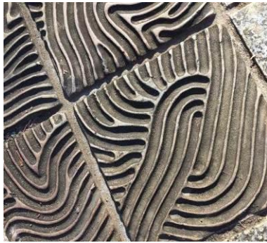
図 1 22 年前に施工されたタイル
