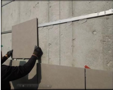
図1 タイルの剥離・落下を防止する「ガチロック」工法
