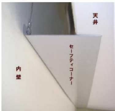
図 1 天井板落下防止用耐震部材
