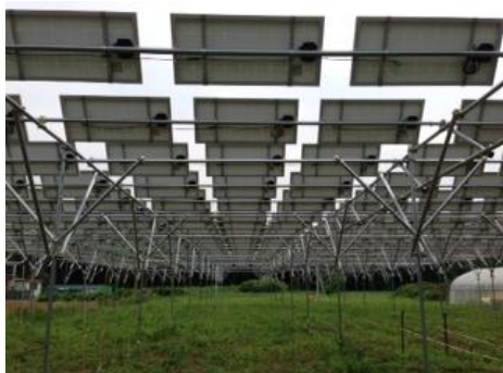
図 4 回動式ソーラーシェアリングシステム
