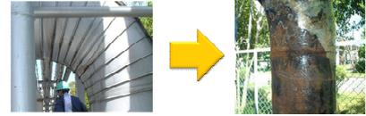
図 1. 劣化(外面腐食)の発生状況
