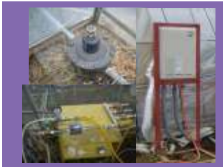
温湯供給装置
