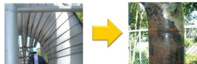
図 1. 劣化 (外面腐食) の発生状況
