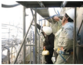
耐震補強工事における配筋探査調査
