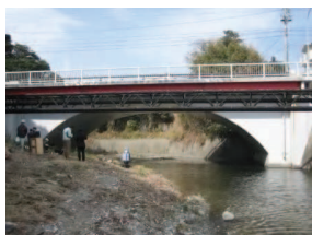
FMレーザーレーザによる橋梁測定実験
