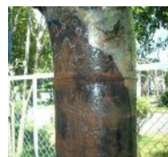
配管の外面腐食
