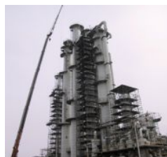
反応塔の検査状況
