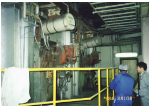
図10 フィールド試験実施中のゴミ焼却炉
