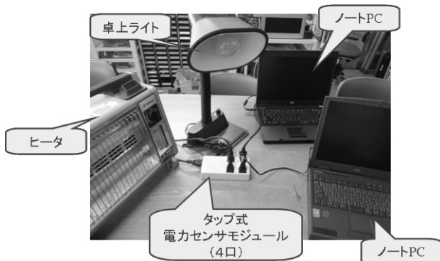
図8 タップ式電力センサモジュールの設置状況
