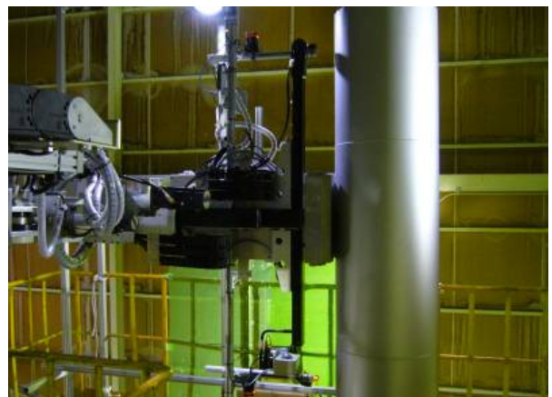
図 7 レール方式の垂直配管へのセット状況
